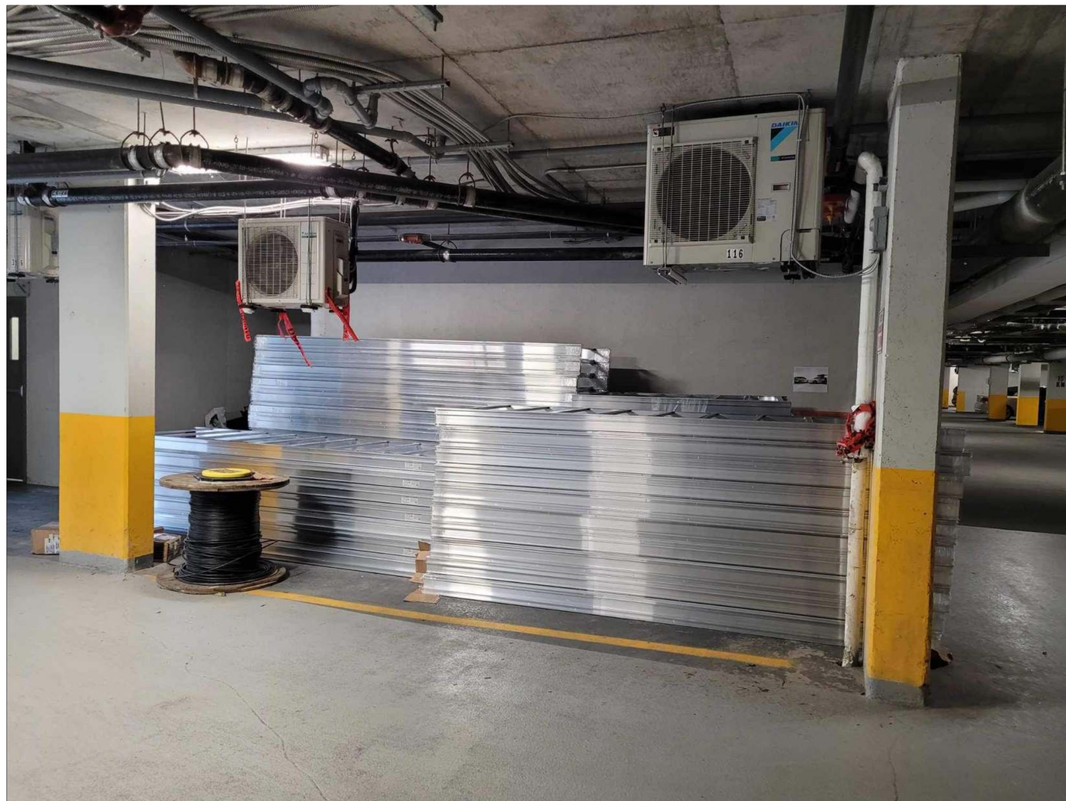
Livraison des chemins de câbles
