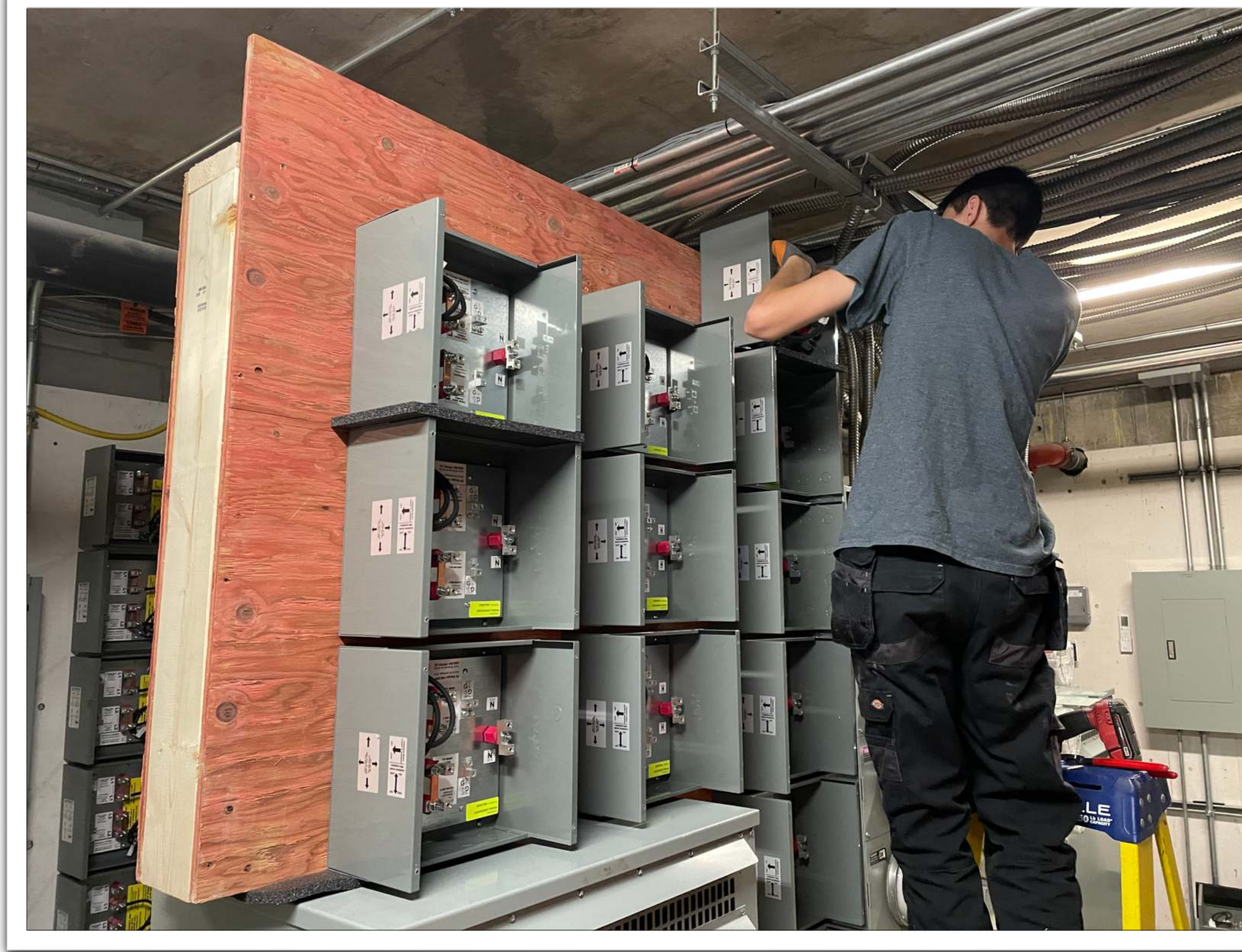
Construction du mur des DCC
