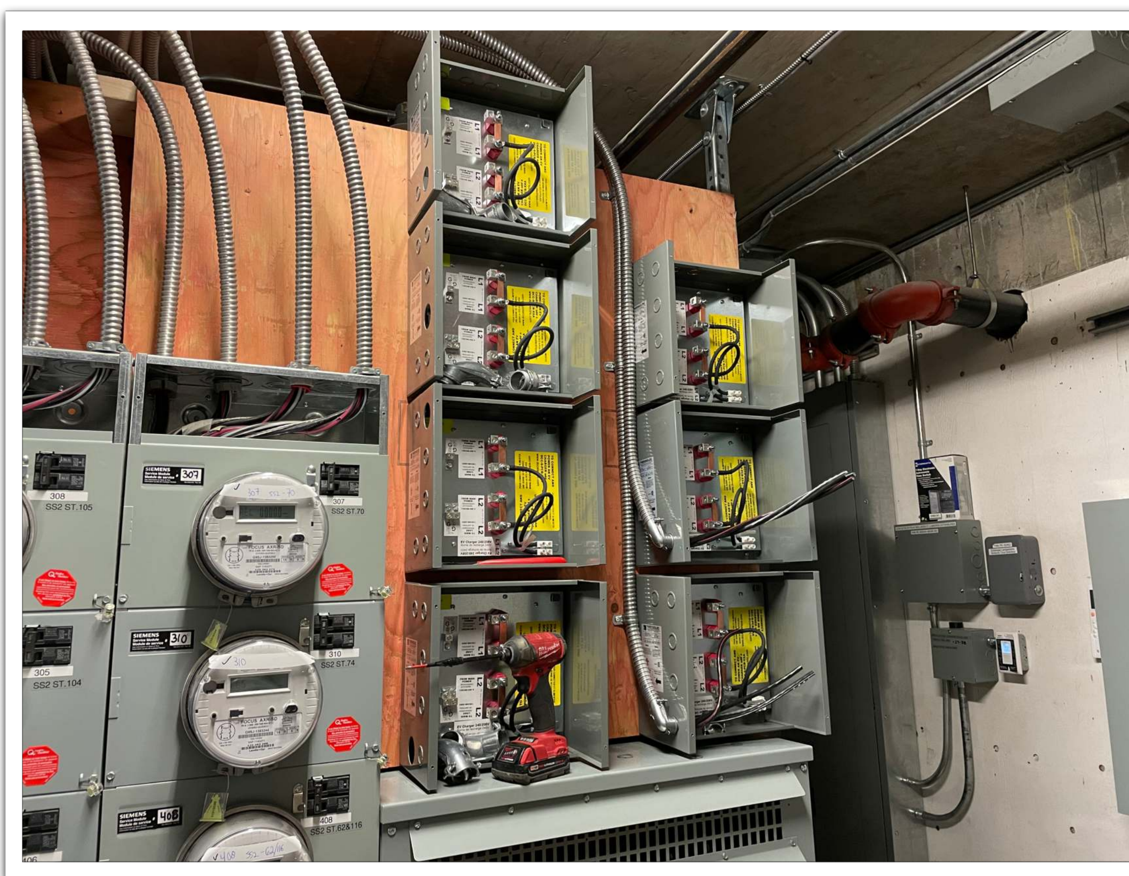
Préparation du filage vers les DCC
